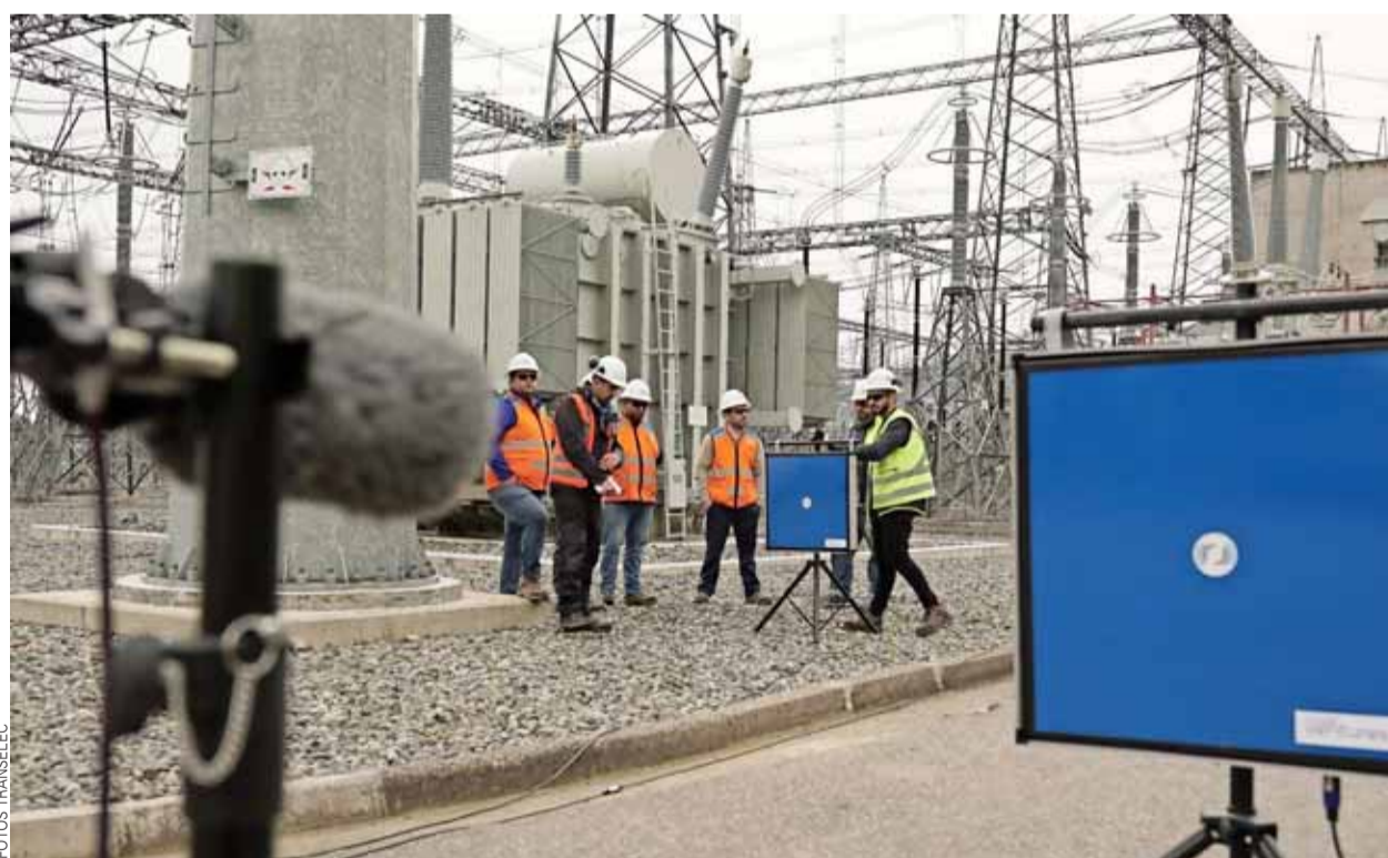
Uno de los proyectos más exitosos surgidos de Transelec Ventures es el piloto de cancelación de ruido usando paneles en la subestación Ancoa, en la Región del Maule.
